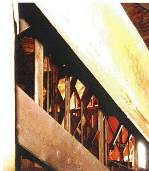
Détails de l'entre-toit. Un casse-tête de pièces de bois à mettre en place.
