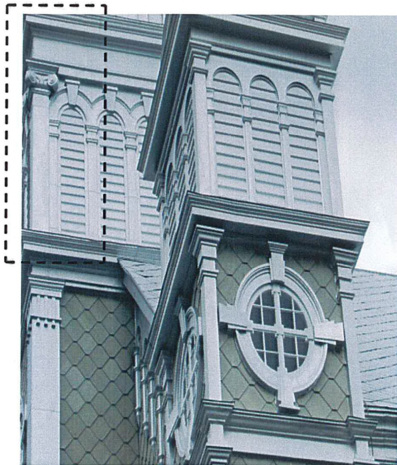
Détails de l'ornementation de tôle des clochers. Détails du coin supérieur gauche de la base du clocher principal.
