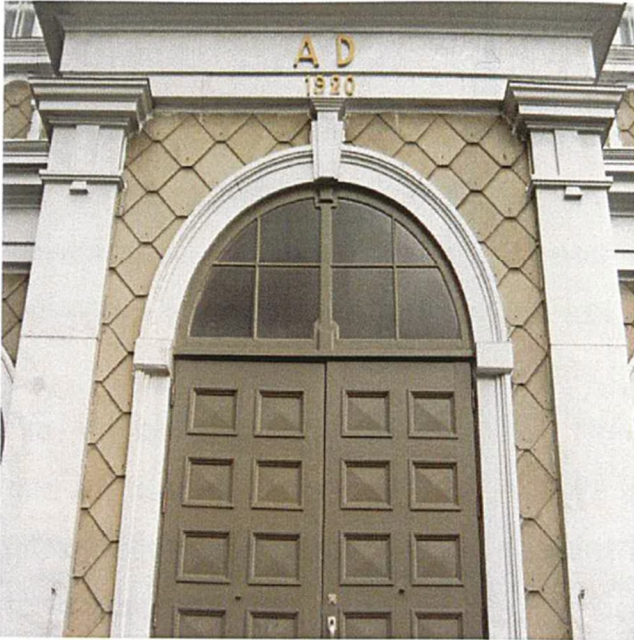
Détails de la porte principale. Bois en pointes de diamant et colonnade de tôle.
