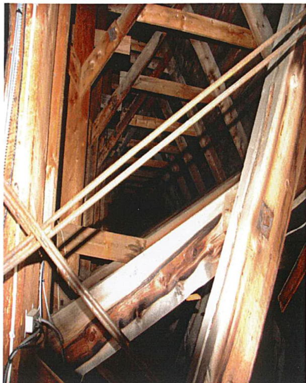
Détails de l'entre-toit. Habile entrecroisement de gigantesques poutres.
