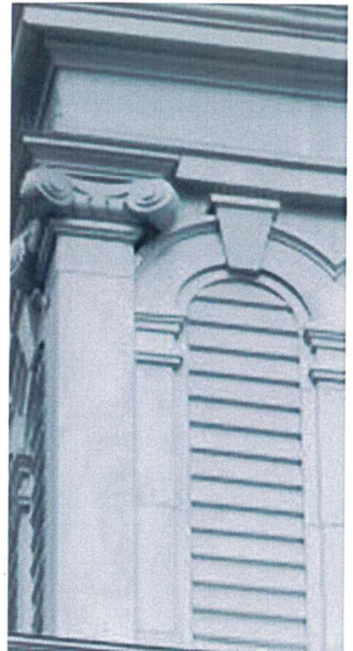
Détails de l'ornementation de tôle des clochers. Détails du coin supérieur gauche de la base du clocher principal.
