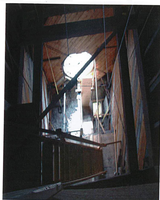
Vue en contre-plongée vers l'œil de bœuf du clocher central.
