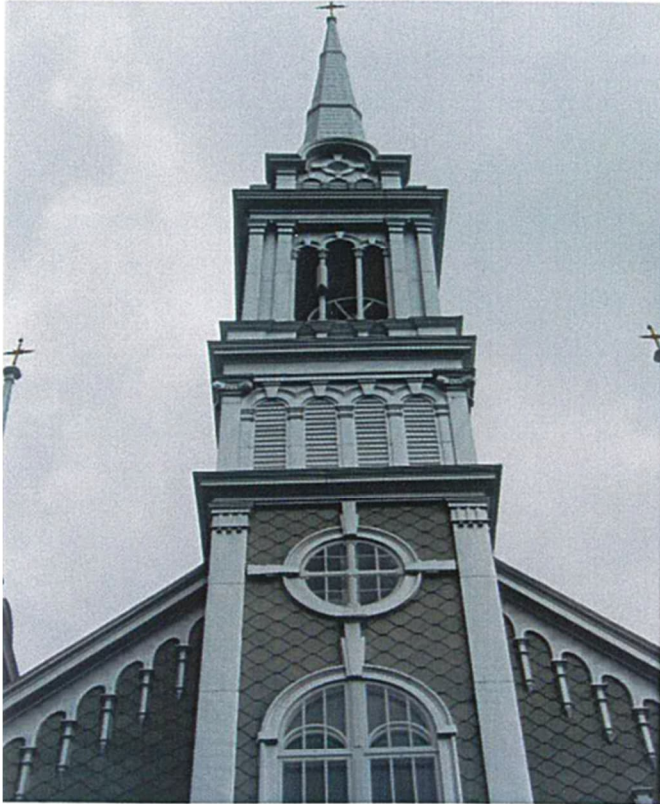
Détails du clocher central. Ornements de tôle autour de l'œil-de-bœuf et sur la flèche du clocher principal. La flèche atteint 175 pieds.
