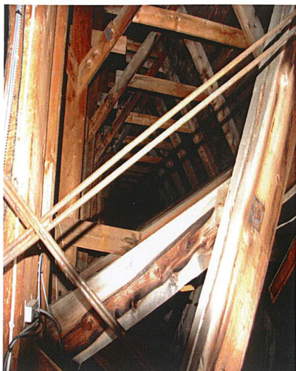
Détails de l'entre-toit. Habile entrecroisement de gigantesques poutres.
