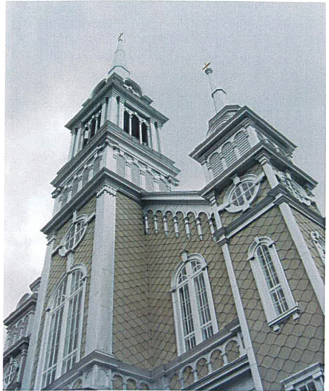
Détails de la façade et du clocher de droite. L'ornementation de tôle autour des fenêtres et à la base des clochers.
